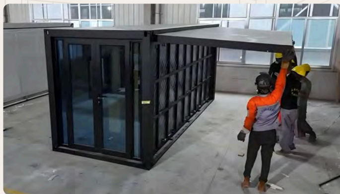
2. Поднимается крыша Формируется высота дома и расширяется внутренний объём.
