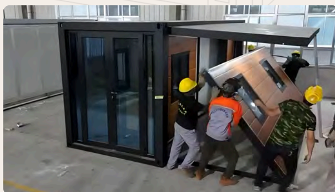
4. Разворачивается стеновой модуль Откидная панель превращается в стену с оконными проёмами.
