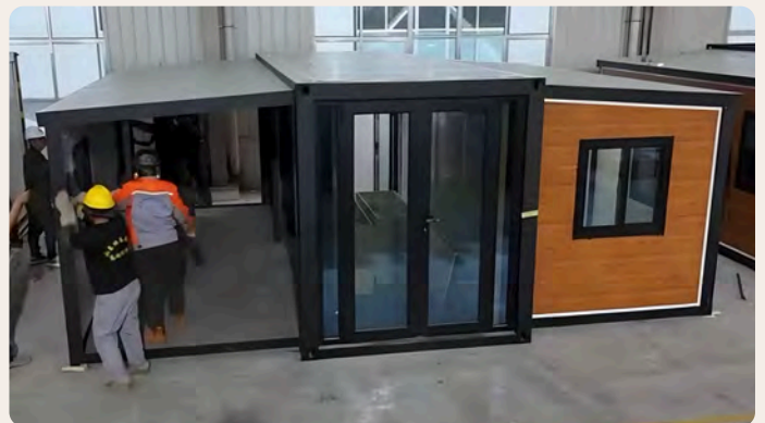
10. Формирование внутреннего пространства Оставшиеся элементы раскладываются и фиксируются.
