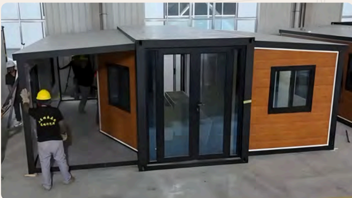
11. Раскрытие внешних модулей Панели защёлкиваются, всё выравнивается.
