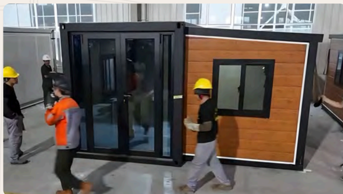
6. Фасадная отделка и финальная фиксация секции Панели защёлкиваются, всё выравнивается.
