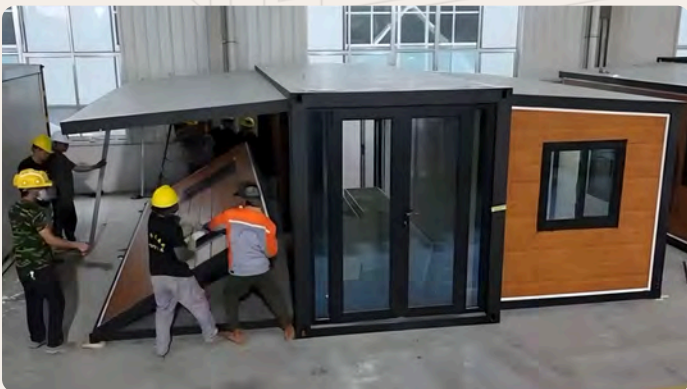
9. Разворачивается стеновой модуль Откидная панель превращается в стену с оконными проёмами.
