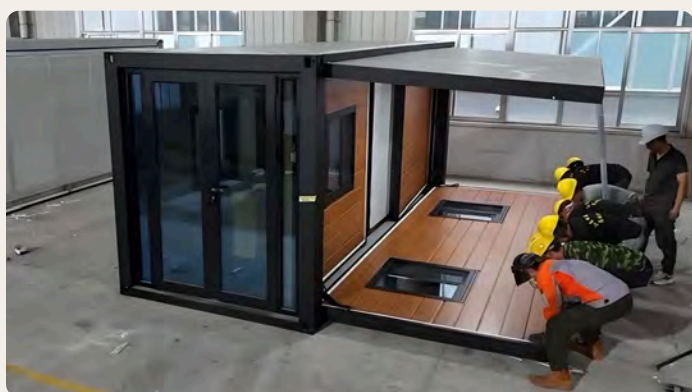
3. Раскрытие боковой секции Боковая часть откидывается наружу.
