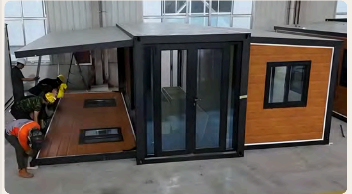
8. Раскрытие боковой секции Боковая часть откидывается наружу.
