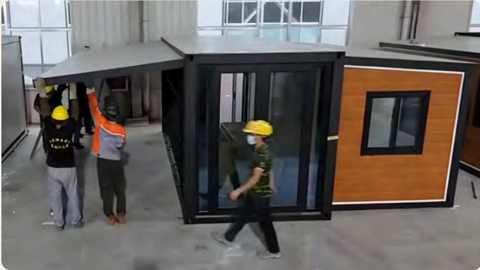
7. Поднимается крыша Формируется пространство правого крыла.
